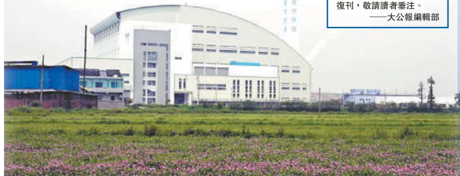
內地的生活垃圾焚燒發電廠
